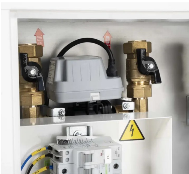
Рисунок 17: Место установки датчика температуры (распределитель установлен)
