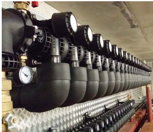
Фотография показывает 27-контурный коллектор ProCalida GT3 в системе грунтового теплообменника теплового насоса. Система находится в торговом центре Huta в местечке Węgierska Górkа (Южная Польша).
